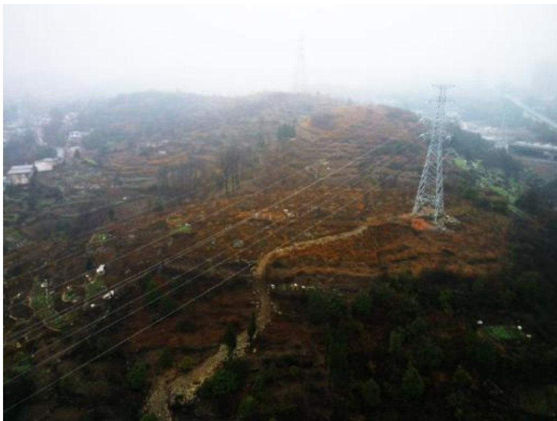
图 4-2 调查地块东南侧无人机航拍图
