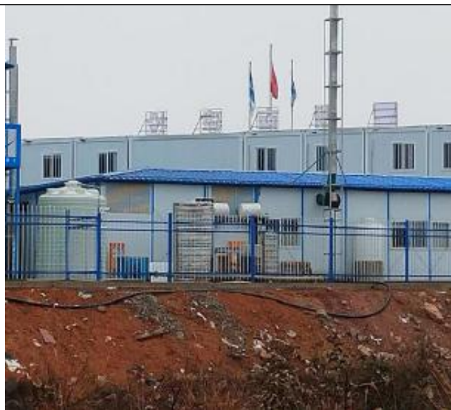
地块周边南面湖南建投施工工地现场踏勘图
