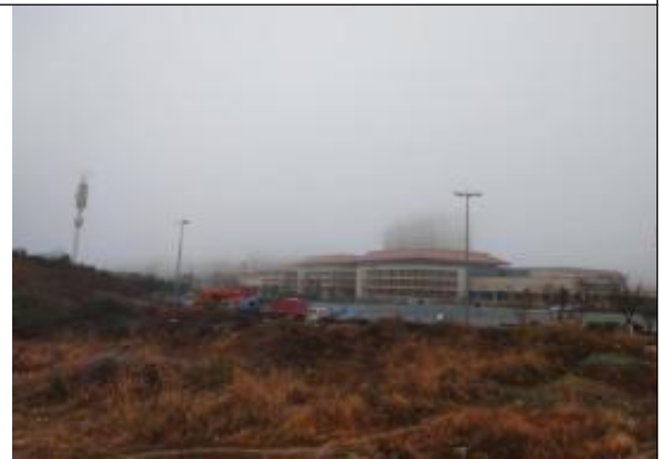
调查地块 ZD-08-01-01 北面现场踏勘图
